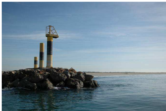
Photo 63: Extrémité de la digue du Grau-Du-Roi
