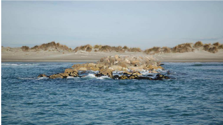
Photo 58: Epi à l'Est de la zone d'étude
