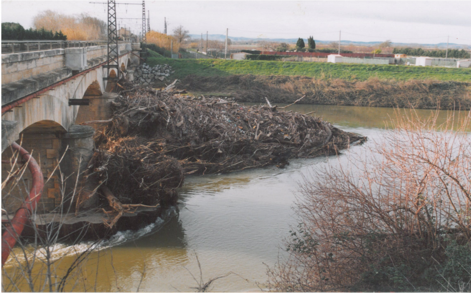
Figure 22 : accumulation d'embâcles au niveau du pont de Coursan (©Lucette Zeller)
