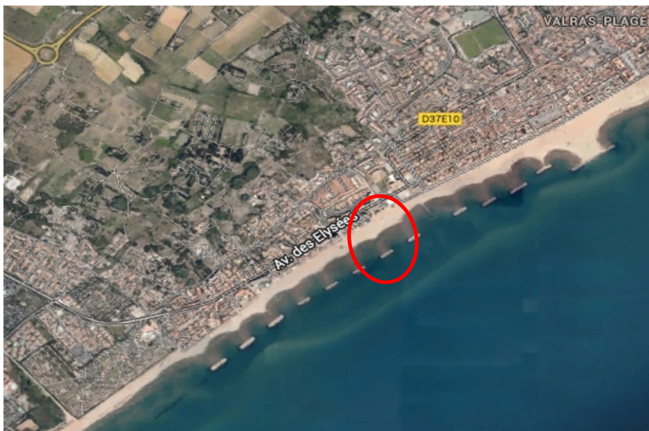
Figure 23 : ouvrages de protection du littoral de Valras-Plage et Vendres-Plage. En rouge : la digue* sous-marine créée en 2008. (Source : Géoportail IGN, 2011)
