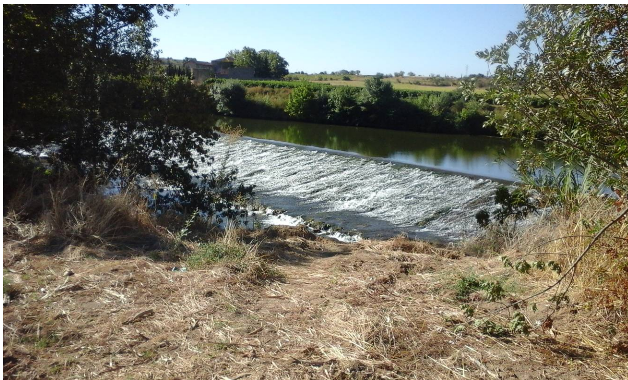
Travaux estivaux réalisés à Moussoulens
