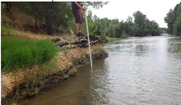
exemple de berge érodée
