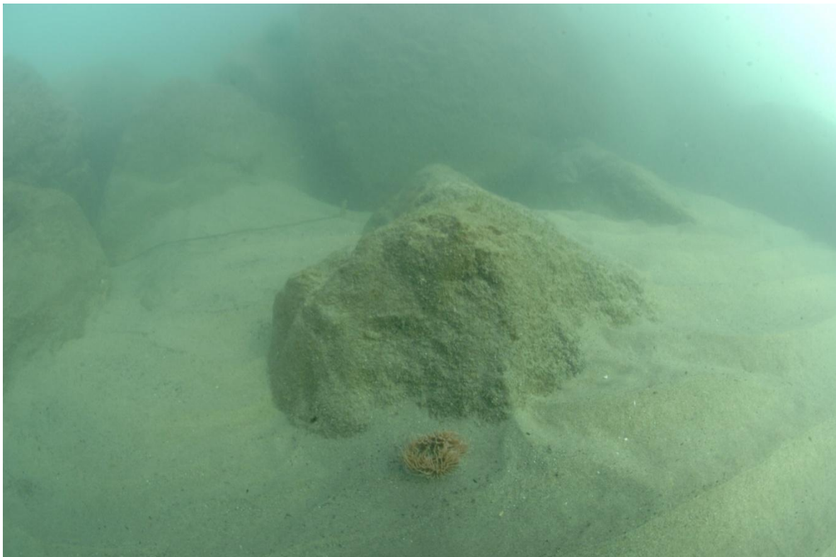
Photo 22 : Enrochement artificiel de la digue du Grau-Du-Roi sur Sables Fins de Haut Niveau
