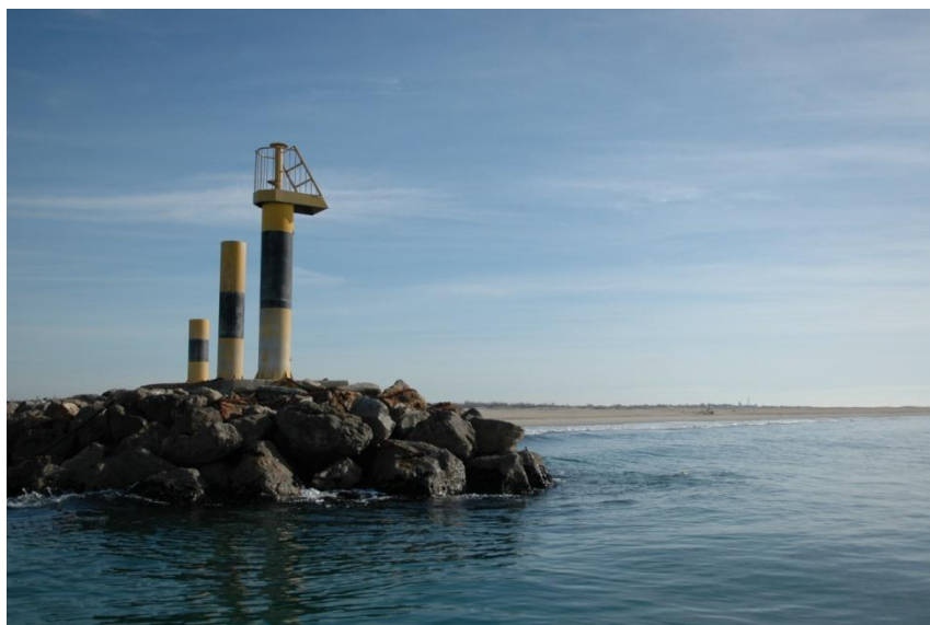
Photo 59 : Extrémité de la digue du Grau-Du-Roi
