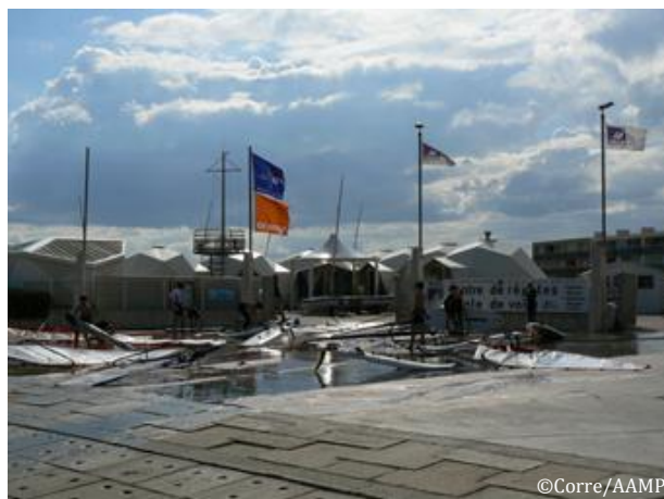
Photographie 73 : Centre nautique municipal.
