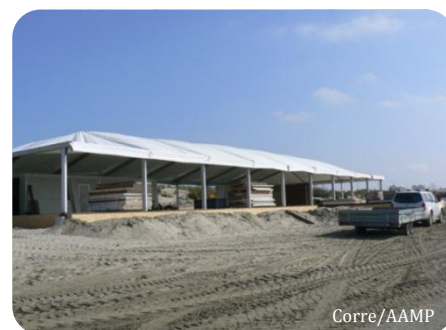
Photographie 22 : Montage d'une plage privée.
