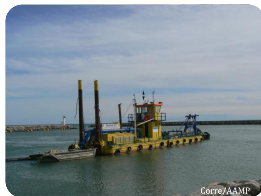
Photographie 23 : Dragage hydraulique dans l'avant-port de Carnon
