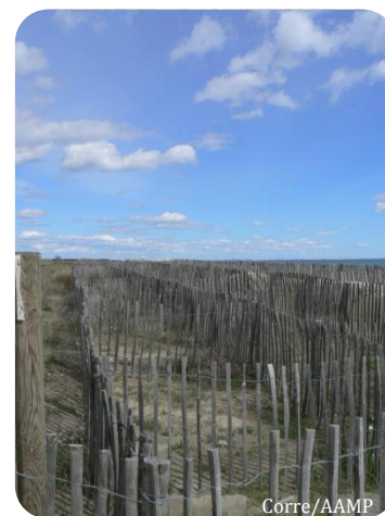
Photographie 19 : Stabilisation de la dune de Grand Travers à l'aide de ganivelles.
