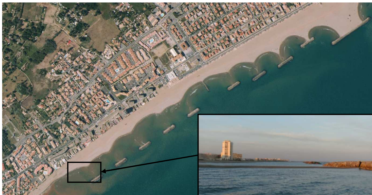
Photo 24 : Accumulation sédimentaire derrière un enrochement artificiel de Valras-Plage constaté entre 2009 (date de la photographie aérienne) [1] et 2012 (date de la photographie de vérité terrain) [2]
