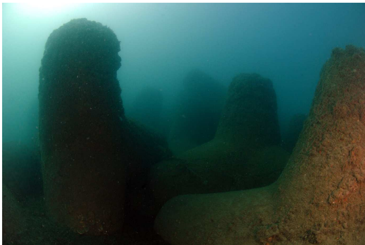
Photo 61 : Tétrapodes au niveau du port de Port-La- Nouvelle
