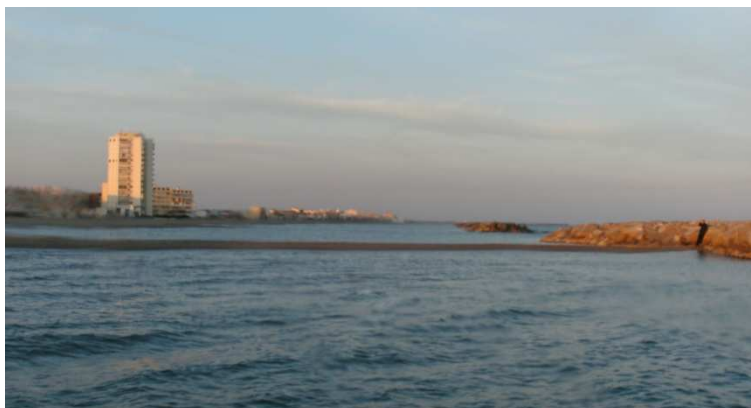
Photo 47 : Zone d'accrétion sédimentaire en amont d'un épi, à proximité de Valras-Plage
