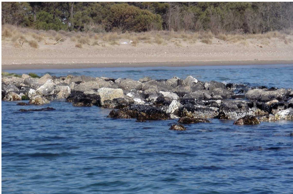
Photo 5 : Enrochement artificiel au niveau du Grau d'Agde
