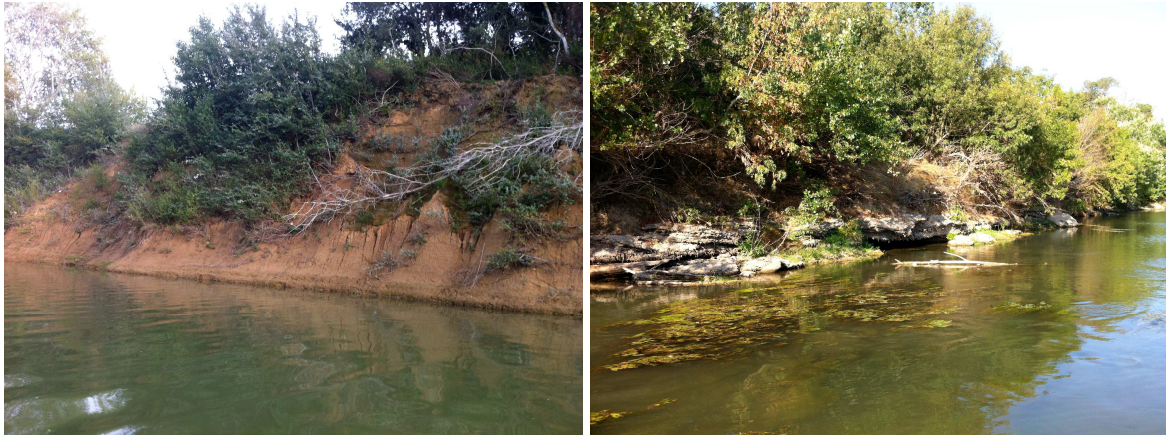
Effet de la chenalisation (encaissement du lit, berge abrupte, disparition des alluvions et délitement de la roche mère : photo de droite, entre Moussoulens et Coursan).
