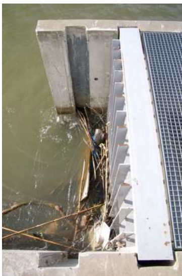
FIGURE 31 : ACCUMULATION D'ENCOMBRES SUR LA GRILLE AMONT (29/04/2012). BLOCAGE PARTIEL D'UNE FENTE VERTICALE PAR UNE SOUCHE D'ARBRE (27/08/2012). MRM
