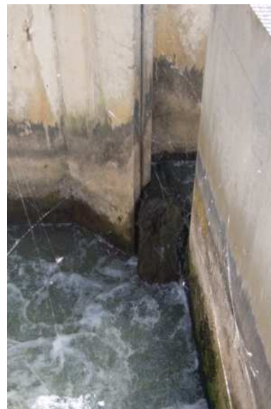
FIGURE 31 : ACCUMULATION D'ENCOMBRES SUR LA GRILLE AMONT (29/04/2012). BLOCAGE PARTIEL D'UNE FENTE VERTICALE PAR UNE SOUCHE D'ARBRE (27/08/2012). MRM
