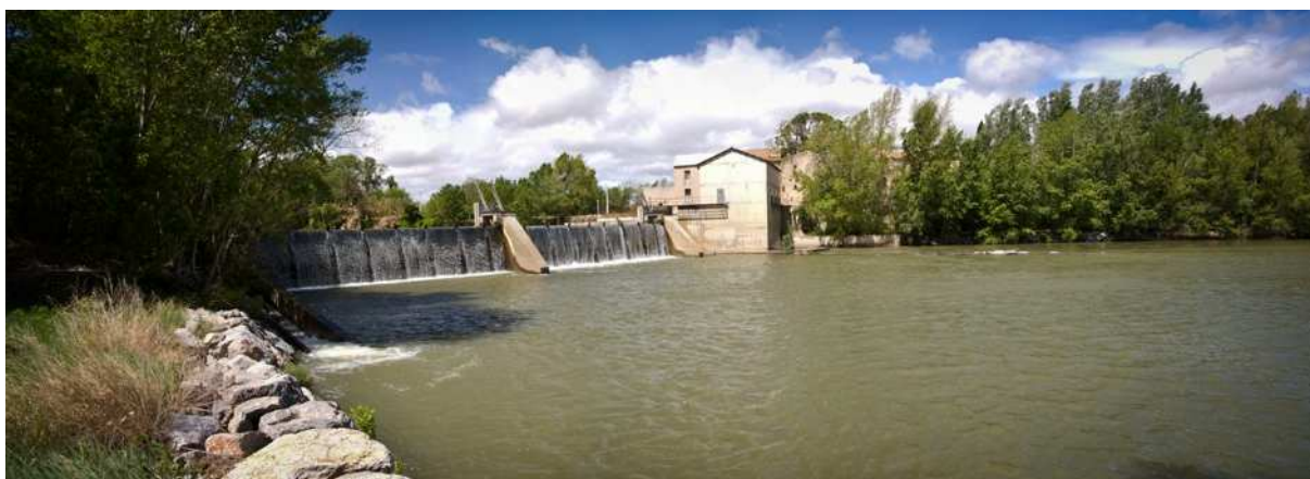
FIGURE 34 : BARRAGE DU MOULIN DE SAINT NAZAIRE. VUE GENERALE DEPUIS L'AVAL. MRM (29/04/2012)
