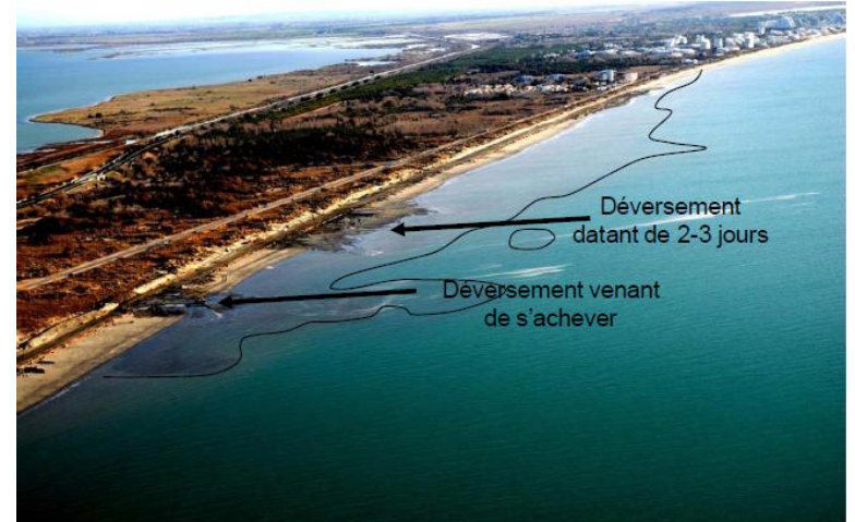
Figure 12: Turbidité liées aux travaux de rechargement des plages
