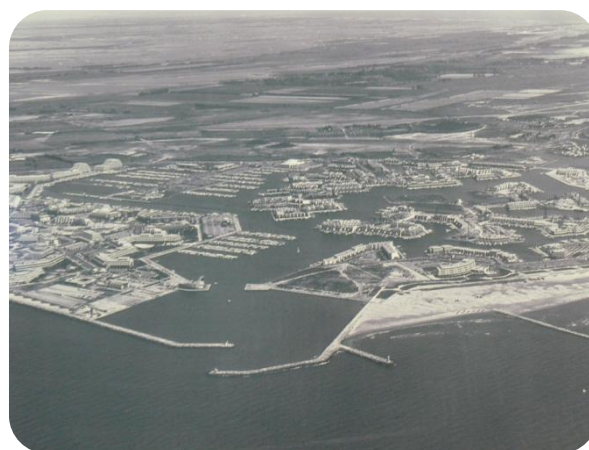
Photographie 15 : Travaux de construction de Port-Camargue (Source : Port-Camargue).
