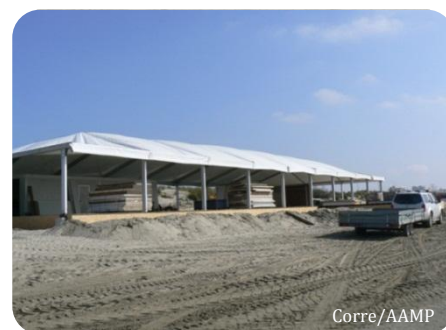
Photographie 22 : Montage d'une plage privée.
