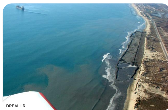
Photographie 20 : Opération de rechargement en sable de la plage du Petit Travers.
