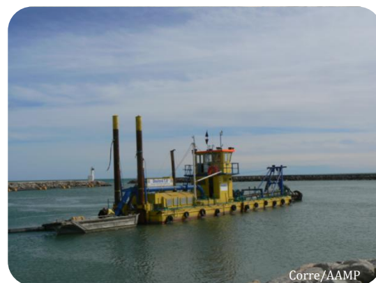
Photographie 23 : Dragage hydraulique dans l'avant-port de Carnon
